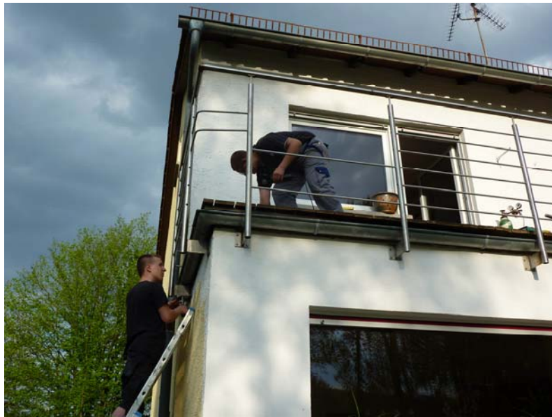
Abb. 4: Montage des Geländers
