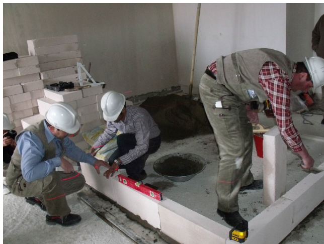
Abb. 6: Praxisworkshop Porenbeton auf der Baustelle in Hashtgerd/Iran
